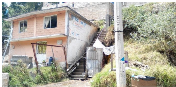
Imagen 129. Asentamiento localizado en la localidad de Ejido los Jarros.
